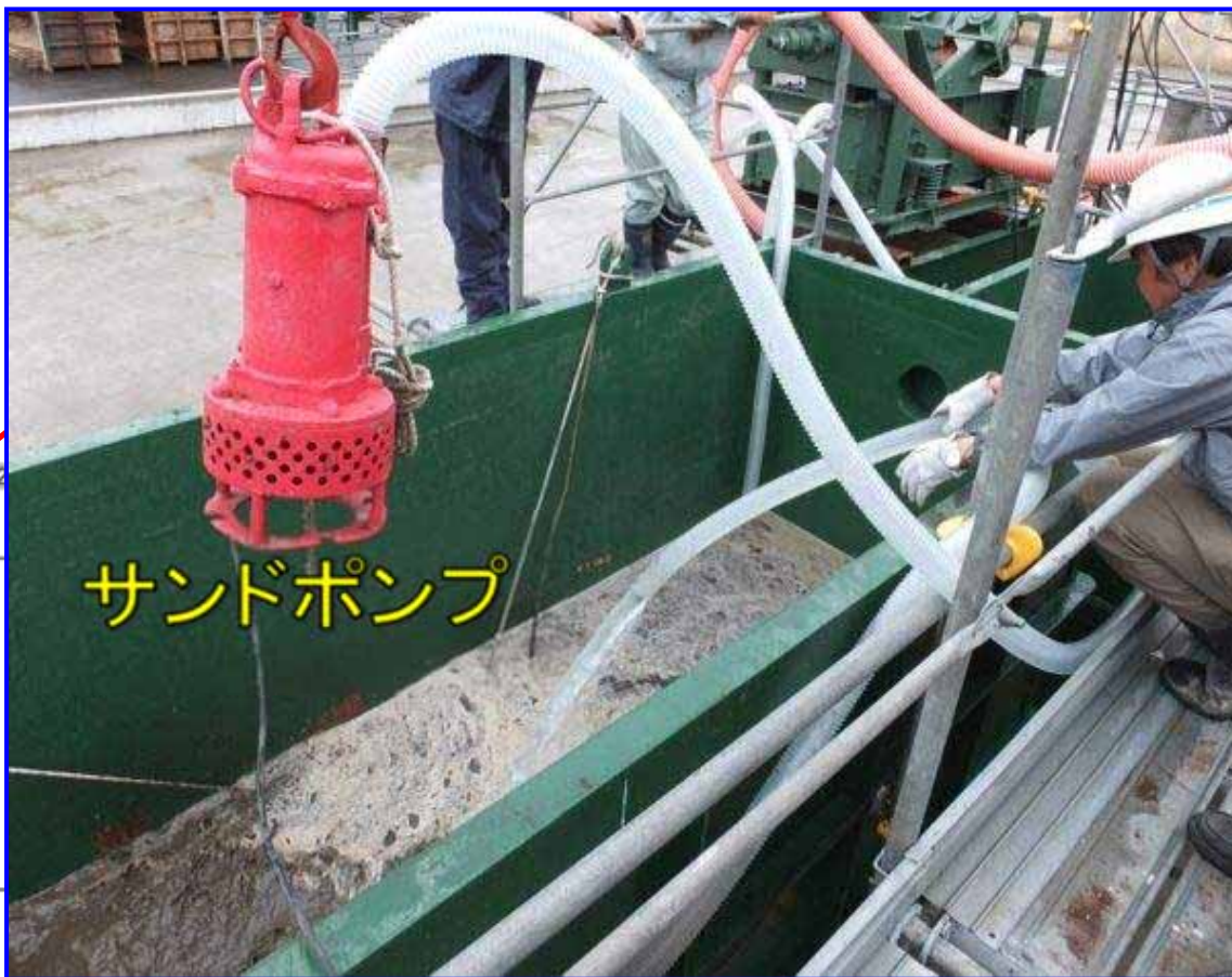
津波堆積物に加水している様子 (循環水を利用)
