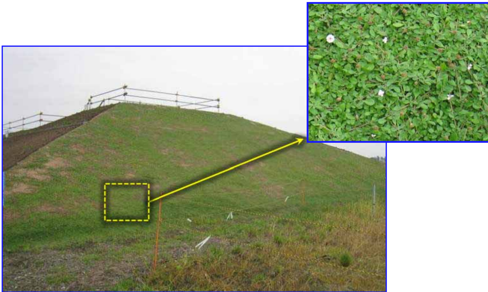
緑化工事から3ヶ月後の植生の様子
