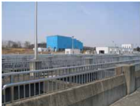
図 下水処理場
